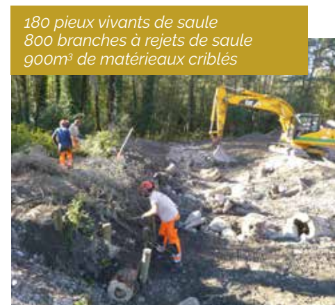
📷 Remise du Boularic dans son lit naturel sur 50 ml, renaturation du lit et végétalisation des berges en génie-végétal
