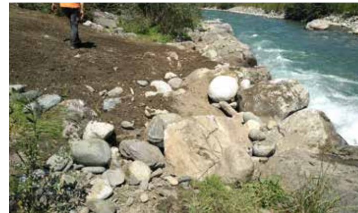
📷 Après travaux - Beaucens
