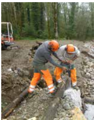
📷 Remise du Boularic dans son lit naturel sur 50 ml, renaturation du lit et végétalisation des berges en génie-végétal
