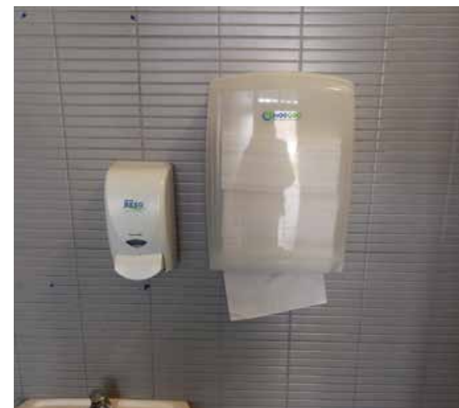
📷 Les sanitaires ont été mis aux normes.
