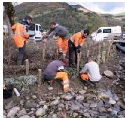
📷 Remise du Boularic dans son lit naturel sur 50 ml, renaturation du lit et végétalisation des berges en génie-végétal
