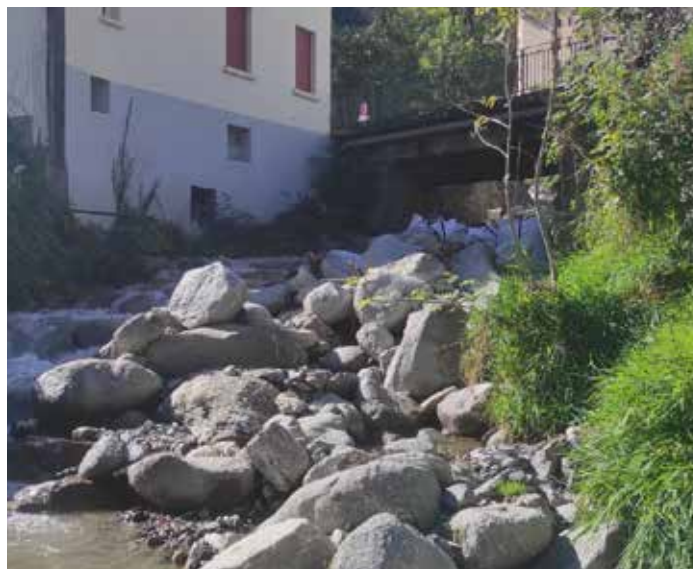
📷 Avant travaux - AVAL
