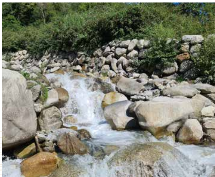
📷 Avant travaux - AMONT
