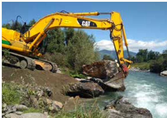
📷 Travaux d'urgence sur enrochement (Beaucens)
