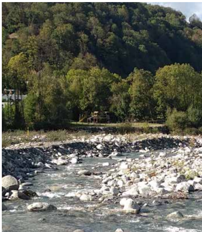
📷 Avant travaux : Bastan - Barès
