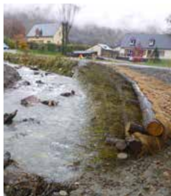
📷 Remise du Boularic dans son lit naturel sur 50 ml, renaturation du lit et végétalisation des berges en génie-végétal
