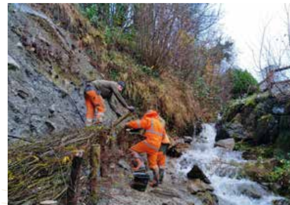
📷 Stabilisation et végétalisation des berges du Souet (Gaillagos)
