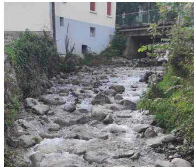
📷 Après travaux - AVAL
