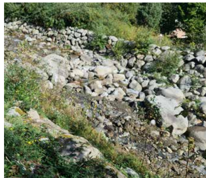
📷 Après travaux - AMONT
