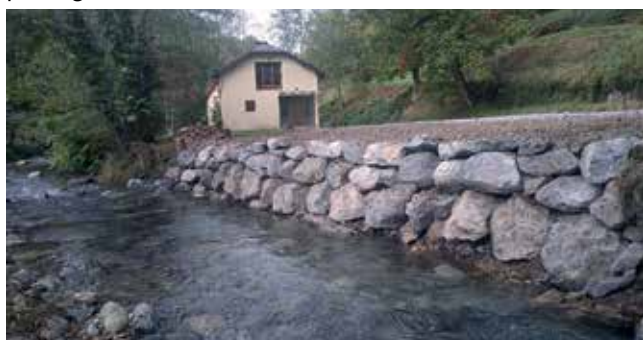
📷 Enrochement d'un propriétaire privé sur Juncalas
