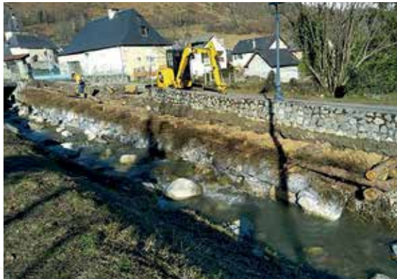
Réalisation d'un ouvrage en génie mixte (enrochement/génie végétal) pour limiter les érosions de berges le long du Boularic
