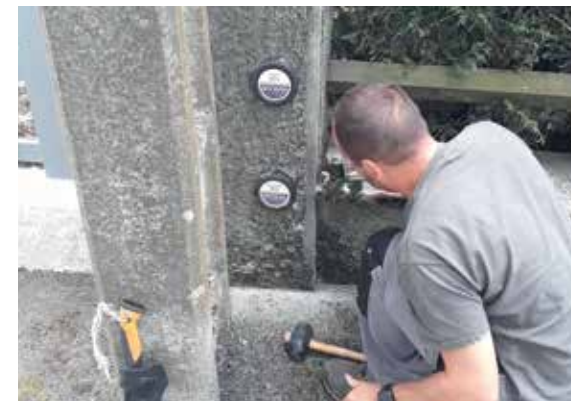
📷 Pose de repères de crue pour matérialiser les hauteurs d'eau atteintes dans le passé
