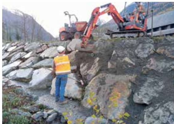
📷 Tests de végétalisation d'engrochements, par des saules pour favoriser la biodiversité, limiter les espèces invasives et les coûts d'entretien
