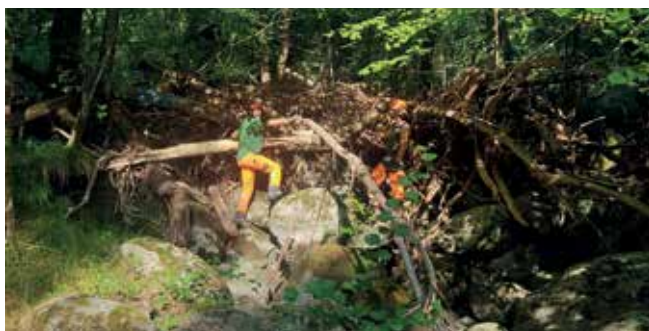
📷 Embâcles avant travaux
