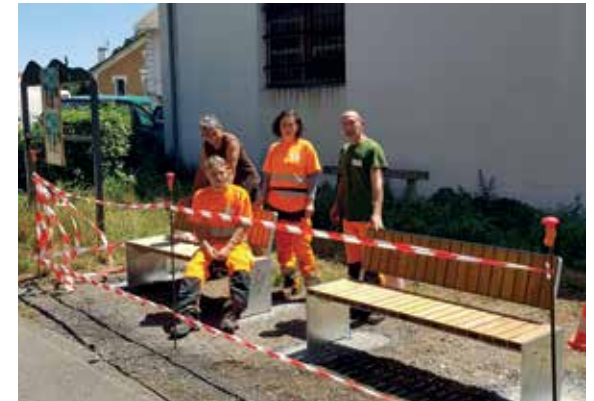
Pose de mobilier le long de la voie verte
