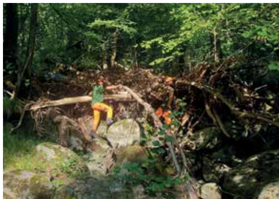
📷 Nettoyage du Bergons par la Brigade Verte et le chantier d'insertion
