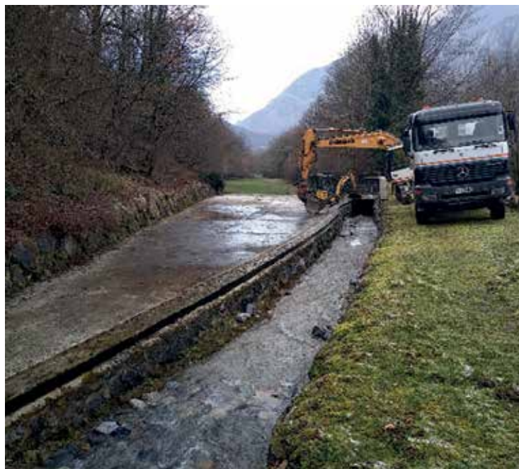
📷 Enlèvement des blocs en amont de l'ouvrage de dérivation
