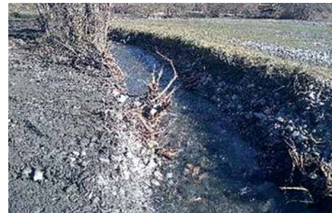
📷 Dégravement du lit principal pour rétablir l'écoulement des eaux
