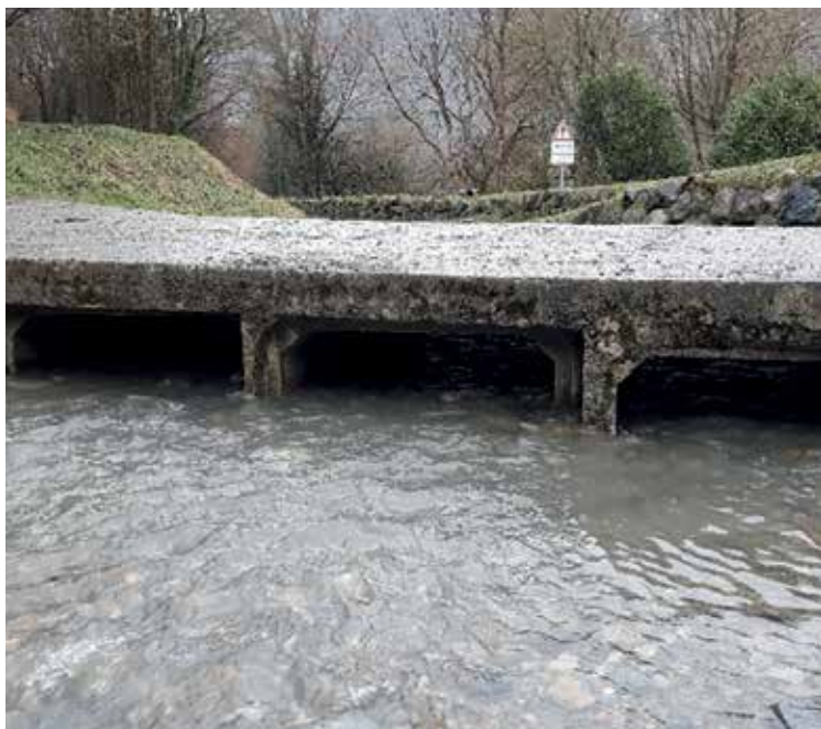
📷 Buses du passage à gué dégravées
