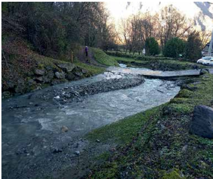
📷 Zone d'enlèvement des matériaux avant travaux
