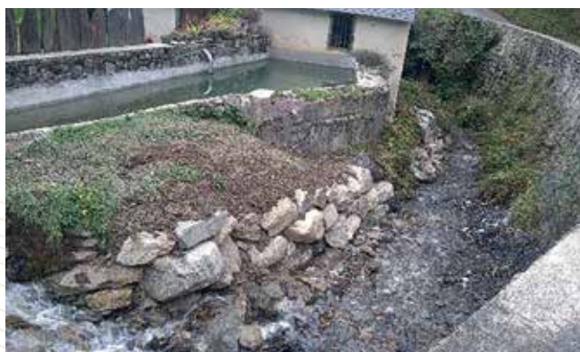
📷 Travaux de renfort de berge sur le Louey pour la commune d'Ourdis-Cotdoussan
