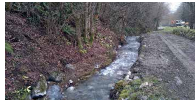
📷 Enrochement après travaux
