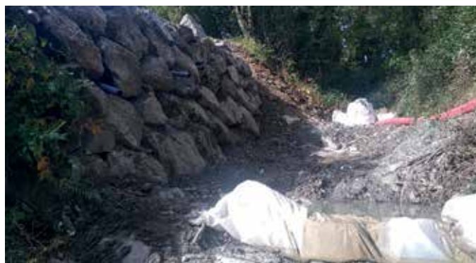
📷 Enrochement sur le ruisseau du Hoo à Arrens-Marsous
