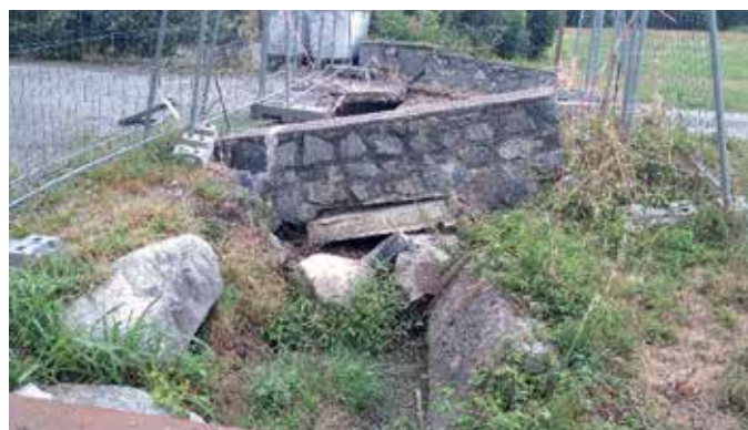
📷 Travaux de mise en place d'un passage cadre sur le ruisseau des Moulins à Agos-Vidalos en remplacement de l'ancien pont détruit à la suite des inondations de décembre 2021 et janvier 2022.
