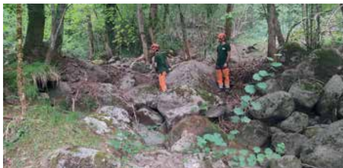
📷 Embâcles après travaux
