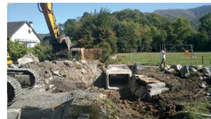
📷 Travaux de mise en place d'un passage cadre sur le ruisseau des Moulins à Agos-Vidalos en remplacement de l'ancien pont détruit à la suite des inondations de décembre 2021 et janvier 2022.
