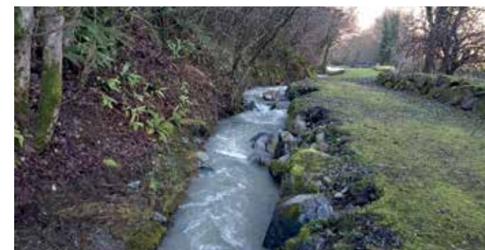
📷 Enrochement endommagé avant travaux
