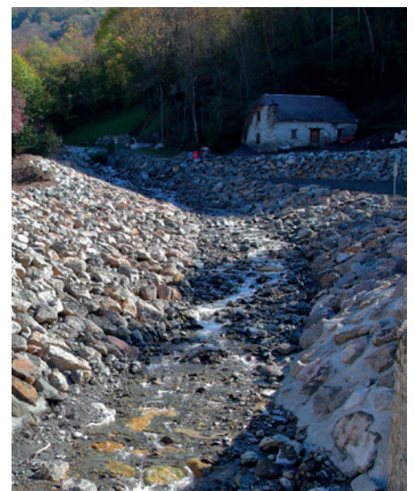
Travaux PAPI 1 (2018) pour le ralentissement dynamique des crues de l'Yse
