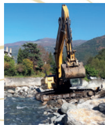
TRAVAUX DE PROTECTION CONTRE LES INONDATIONS SUR OUVrage DU PLVG (POST CRUE 2018)
