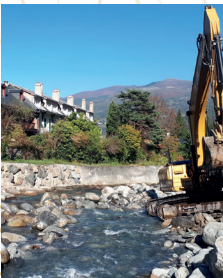
Travaux post-crue 2018 sur le système d'endiguement de Pierrefitte-Nestalas et Soulom
