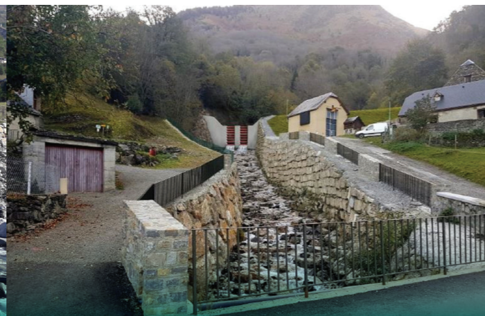
Projet de barrage filtrant sur l'Yse
