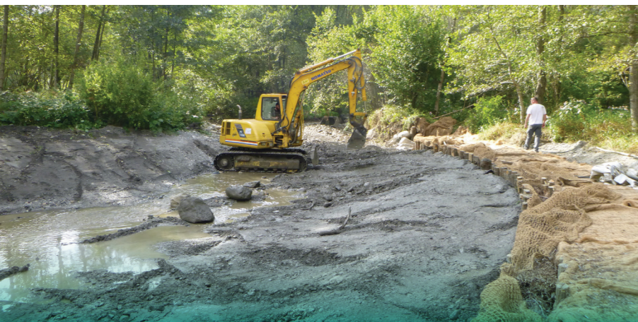
Gave d'Azun Terrassement de la berge et mise en place d'un talus de protection végétal.
