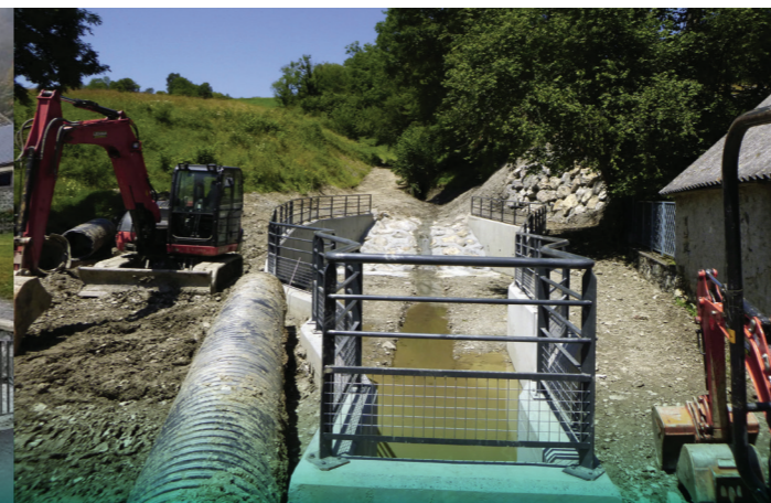
Création d'une plage de dépôt sur le Lingé à Arrens-Marsous
