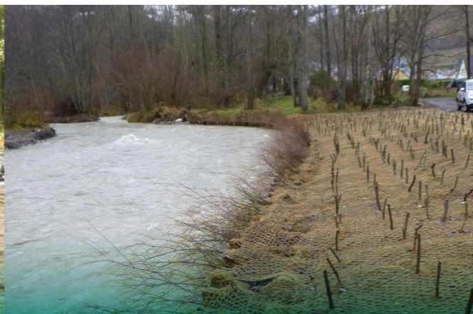
Renaturation de la berge à base de saule drapé ( Salix Eleagnos ) et bâche coco
