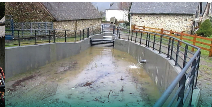
Vue amont de la plage de dépôt sur le Lingé à Arrens-Marsous
