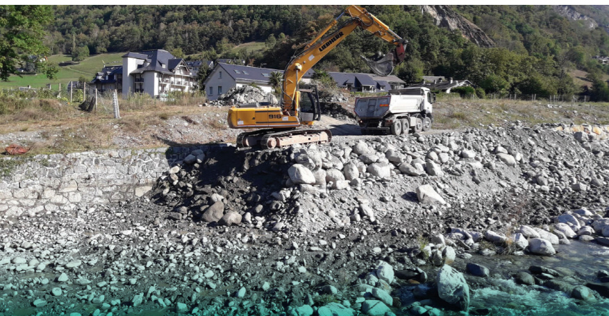
Travaux sur le Bastan et sur l'Yse pour protéger Luz Saint-Sauveur
