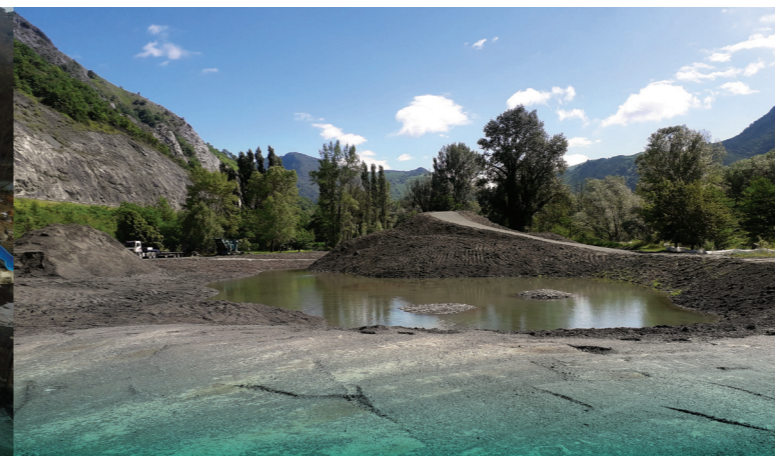
Nivellement de terrain, aménagement d'une zone humide
